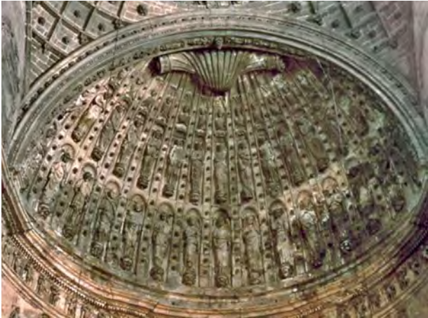
4. Sevilla. Catedral, ábside de la Capilla Real. Martín de Gaínza, construido con hiladas horizontales.
