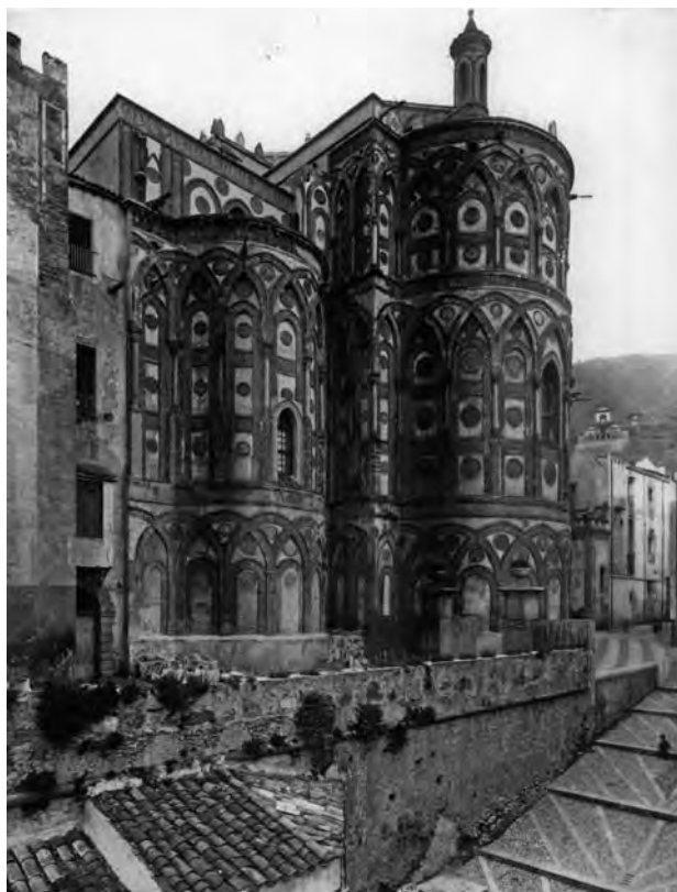
11. Monreale. Duomo, veduta delle absidi (Palermo, Biblioteca Dipartimento di Architettura).
