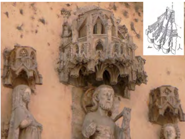
8. Saragozza. Chiesa di San Paolo, tabernacolo che copre la statua del Salvatore della facciata settentrionale, che presenta, come la soluzione adottata nella cattedrale di Toledo, archi rampanti divergenti in alzato.
