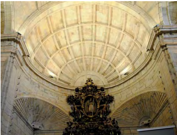
8. Orrio (Guipúzcoa). Iglesia parroquial, ábside esférico construido con cruceros con hiladas verticales (foto S. C. Bravo).
