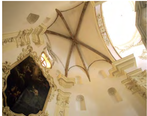
11. Trapani. Complesso dell'Annunziata, volta dell'abside originaria della chiesa.
