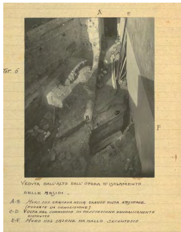
15. Cappella Palatina a Palermo, la parte superiore delle absidi durante i lavori di isolamento eseguiti da Francesco Valenti, 1921-1938 (BCPa, Fondo Valenti, 5 Qq E 14600005).
