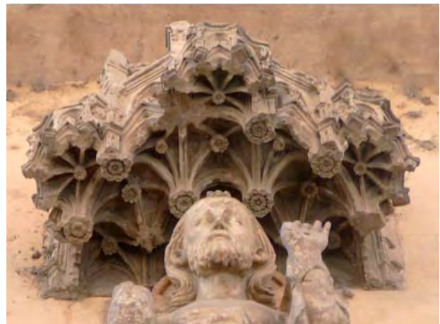
8. Saragozza. Chiesa di San Paolo, tabernacolo che copre la statua del Salvatore della facciata settentrionale, che presenta, come la soluzione adottata nella cattedrale di Toledo, archi rampanti divergenti in alzato.
