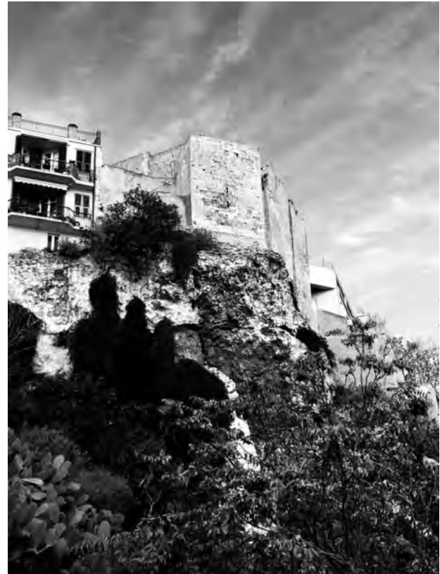
16. Cagliari. Chiesa di Santa Lucia di Castello, torre delle mura orientali del Castello riutilizzata come contrafforte della volta presbiteriale (esterno).
