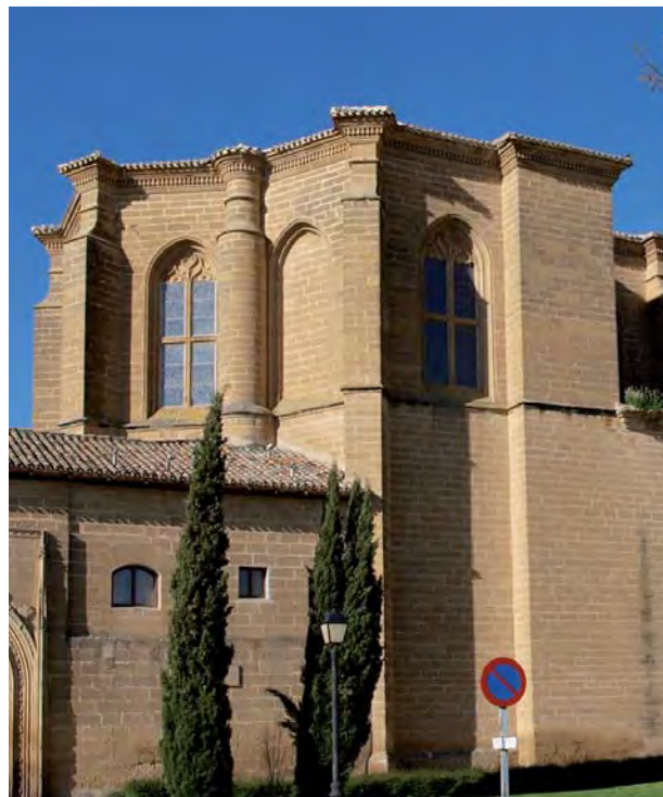
8. Casalarreina (La Rioja). Iglesia de La Piedad, exterior del ábside.
