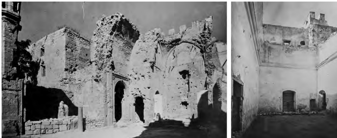
6. Cagliari. Convento di San Domenico, merlatura sulla sommità delle pareti verticali della cappella absidale maggiore, post 1943 (su concessione della Soprintendenza BAPSAE per le province di Cagliari e Oristano).
