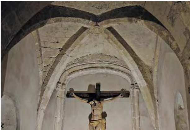
3. Cagliari. Chiesa di San Domenico. Cappella del Crocifisso (XIV secolo), volta a crociera.
