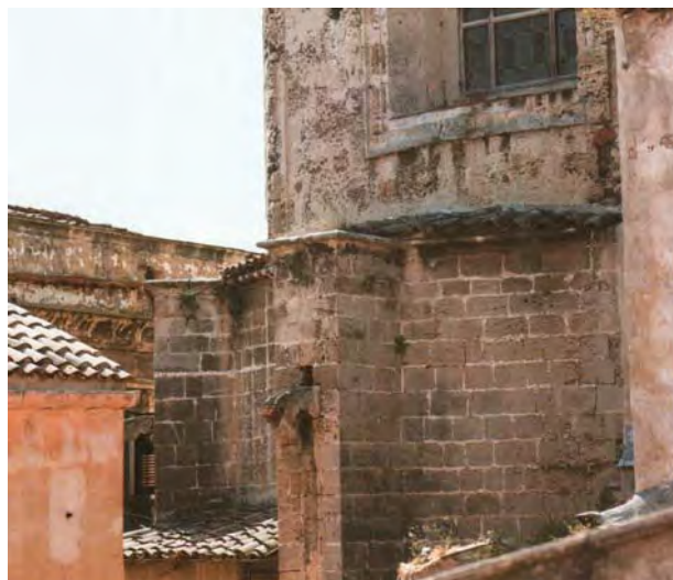
15. Palermo. Chiesa di San Domenico, dettaglio dell'abside con i resti della precedente struttura poligonale.
