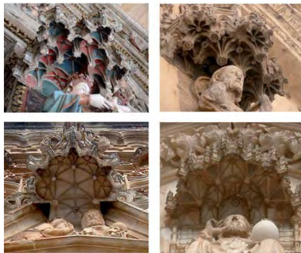
7.1. Pamplona (Navarra). Cattedrale, tabernacolo collocato sulla statua di Nostra Signora della colonna centrale della Puerta del Amparo; 7.2. Saragozza. Chiesa di San Paolo, tabernacolo che copre la statua del Salvatore della facciata settentrionale; 7.3. Monastero di Batalha (Portogalo). Tabernacolo che copre la rappresentazione dell'Incoronazione della Vergine della facciata principale; 7.4. Monastero di Batalha (Portogalo). Tabernacolo che protegge l'immagine di Dio Padre che presiede l'accesso meridionale.
